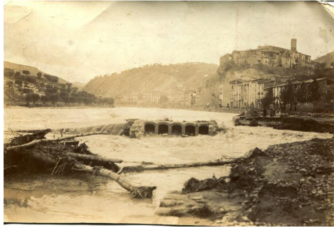
Inundacions de 1907. El Cardener al seu pas per Súria. Les boques al centre de la foto són els estelladors d'entrada al canal Abadal.
