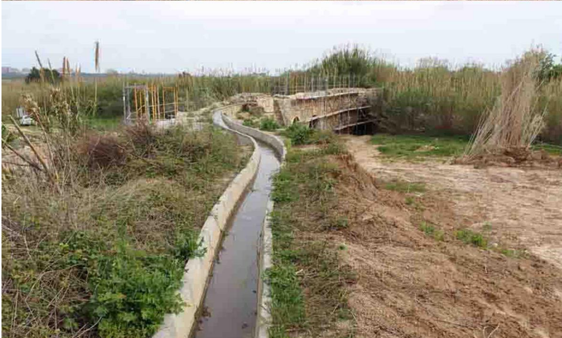
Fig.7. Arriba, el “Pont de Caixes” de Constantí, antiguo acueducto romano reutilizado durante la edad media como soporte al desarrollo de un sistema de irrigación (la Sèquia dels Molins); abajo, detalle de la acequia medieval.
