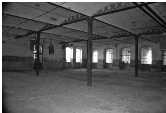
Sala interior de les cardes de la fàbrica Mata y Pons d'Alguairre
