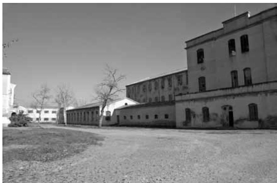
Façana principal de la fàbrica Mata y Pons d'Alguaire
