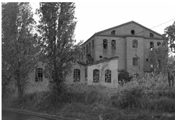
Vista exterior de la fàbrica Mata y Pons d'Alguaire
