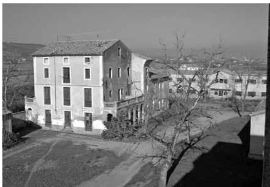
Panoràmica des de l'interior de la fàbrica a la casa dels encarregats de la fàbrica Mata y Pons d'Alguaire
