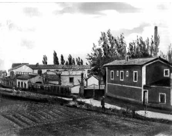
Vista exterior de la fàbrica de paper per embalatges "La Leridana", a Rosselló, de l'any 1924
