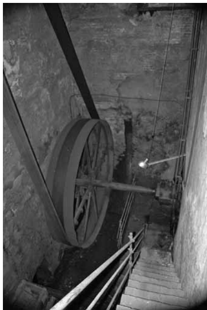
Volant dels embarrats de la turbina de la fàbrica Mata y Pons d'Alguaire
