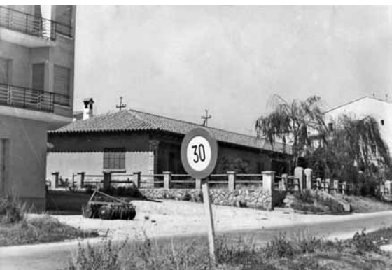
Casetes de la ENHER d'Alfarràs construïdes el 1954 per allotjar treballadors del Pantà de Santa Anna (Castellonroi)
