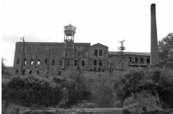
Xemeneia, dipòsit i entrada d'aigua de la segla a la fàbrica Mata y Pons d'Alguaire
